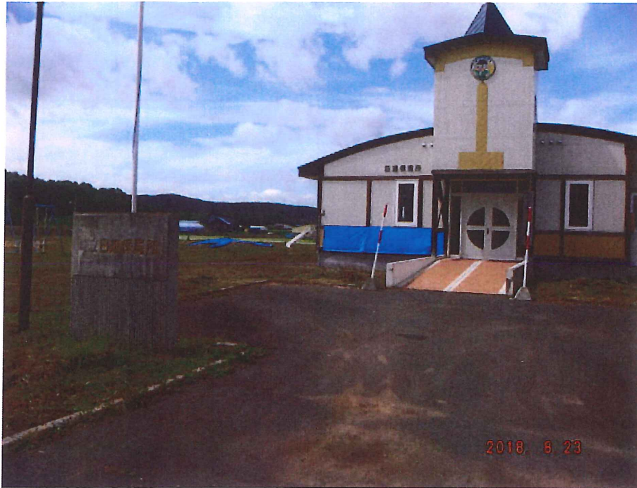
保育所正面玄関付近の状況
