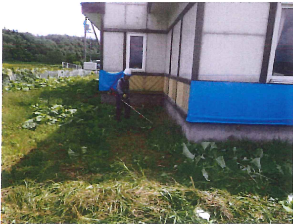
西側軒下の状況
